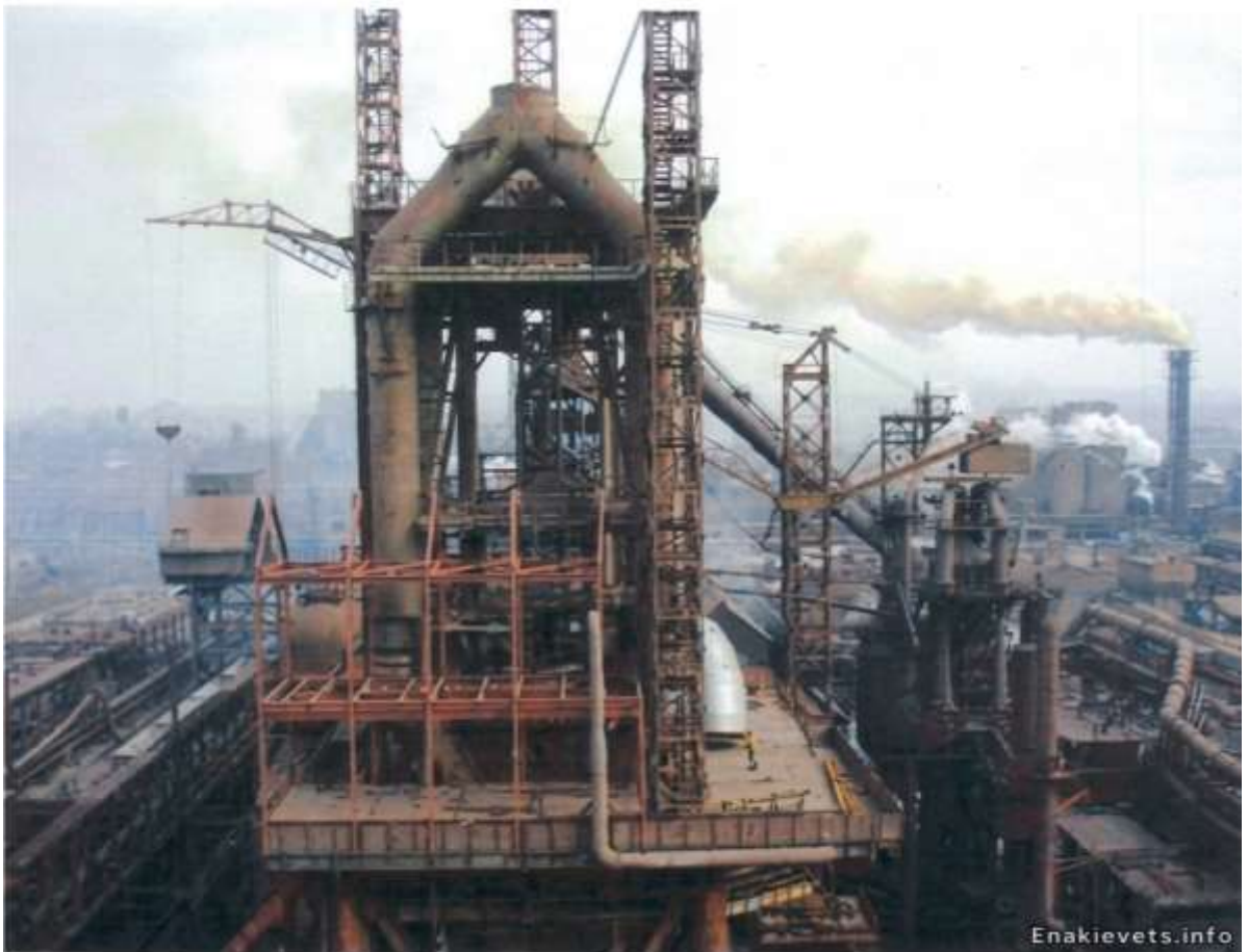
Рис.1.4. Безконусний завантажувальний пристрій
